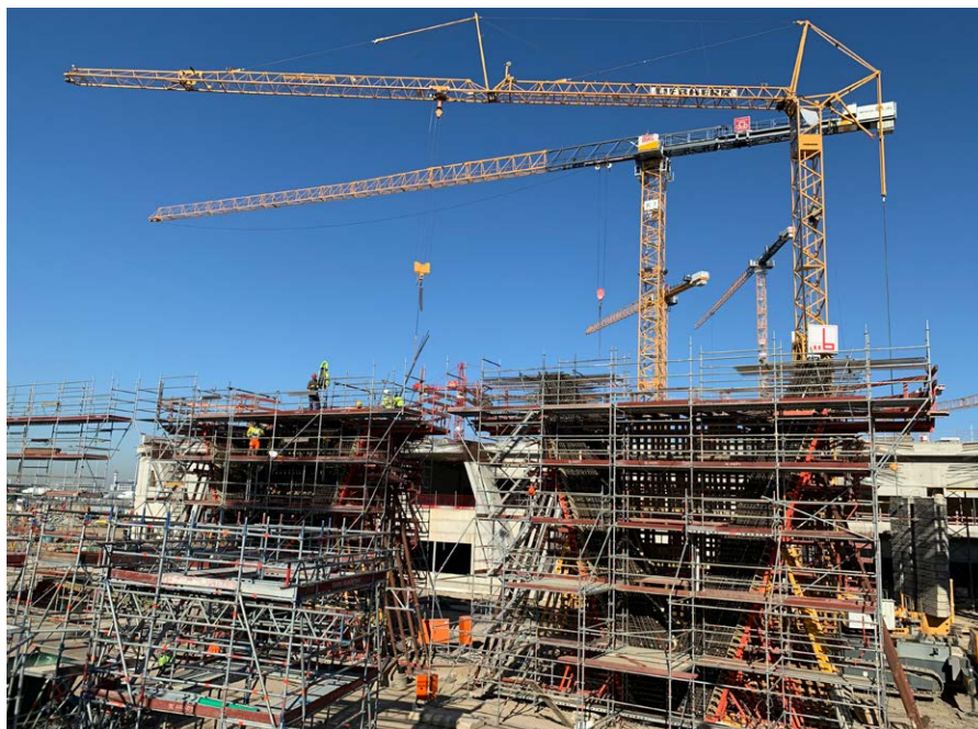
Kluge betont auch die strategische Neuausrichtung der Sicherheitskoordination: „Eine solche Großbaustelle lässt sich nur sinnvoll koordinieren, wenn man nach den eigentlichen Grundlagen der Baustellenverordnung arbeitet: d. h. weniger Sicherheitsfachkraft, die sich in Details von Arbeitsschutzmängeln verliert, sondern mit Blick für das große Ganze den ausführenden Firmen Hilfe zur Selbsthilfe bietet.“
